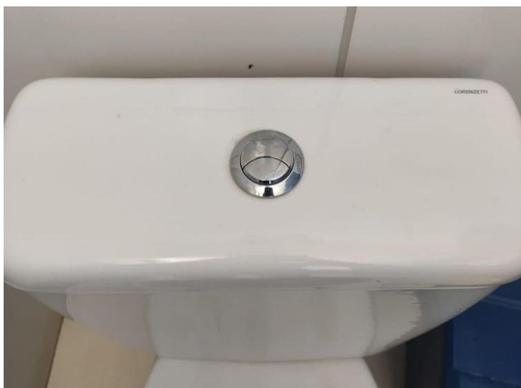
Figura 8. Bacia sanitária com caixa acoplada com duplo acionamento presente no Centro de Engenharias no campus Mossoró/RN.
